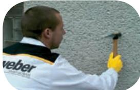
Poklepem je třeba se ujistit, že podkladní omítky jsou v celé ploše spojeny s podkladem.
