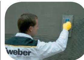
Penetrace podkladu se neprovádí. Stará břízolitová omítka s nepohyblivými trhlinami se celoplošně natáhne tmelem **webertherm min LZS 740**. Povrch tmelu se upraví zubovým hladítkem do vodorovných vln, do výšky 3–4 mm.
