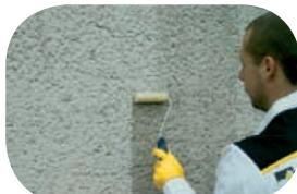
Mírně drolivé nebo sprašující podklady je možno zpevnit **hloubkovým zpevňovačem omítka H707**. Pokud je drolivost vyššího stupně nebo zkouška tvrdosti neprokázala dostatečnou pevnost podkladu, poradte se, prosím, s realizační firmou, odborným prodejem nebo přímo s obchodně-technickým poradcem naší firmy o dalším postupu.
